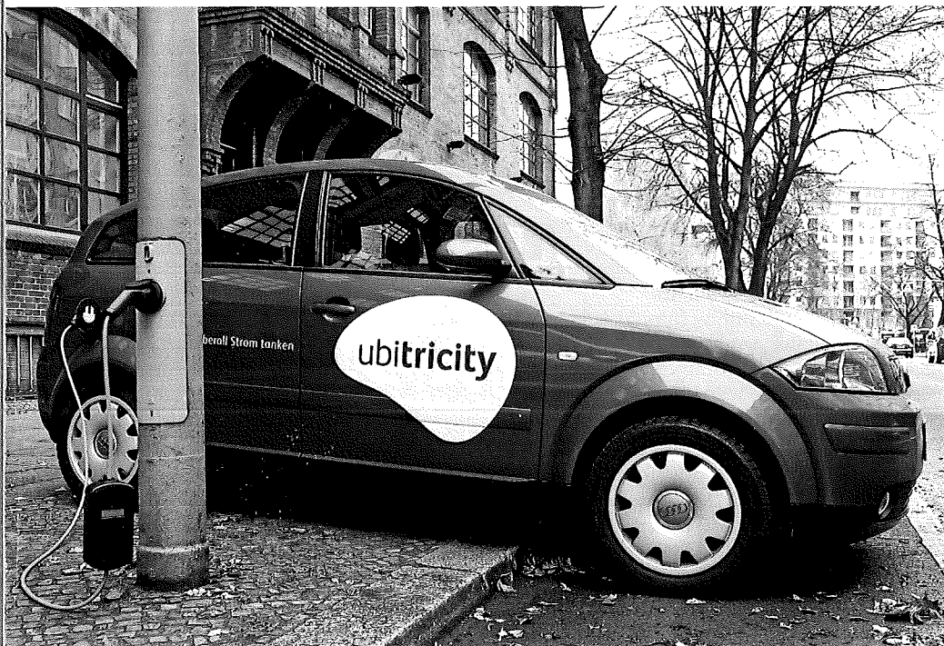
Ubitricity-Ladestation in Berlin: Langsam wachsende Infrastruktur
