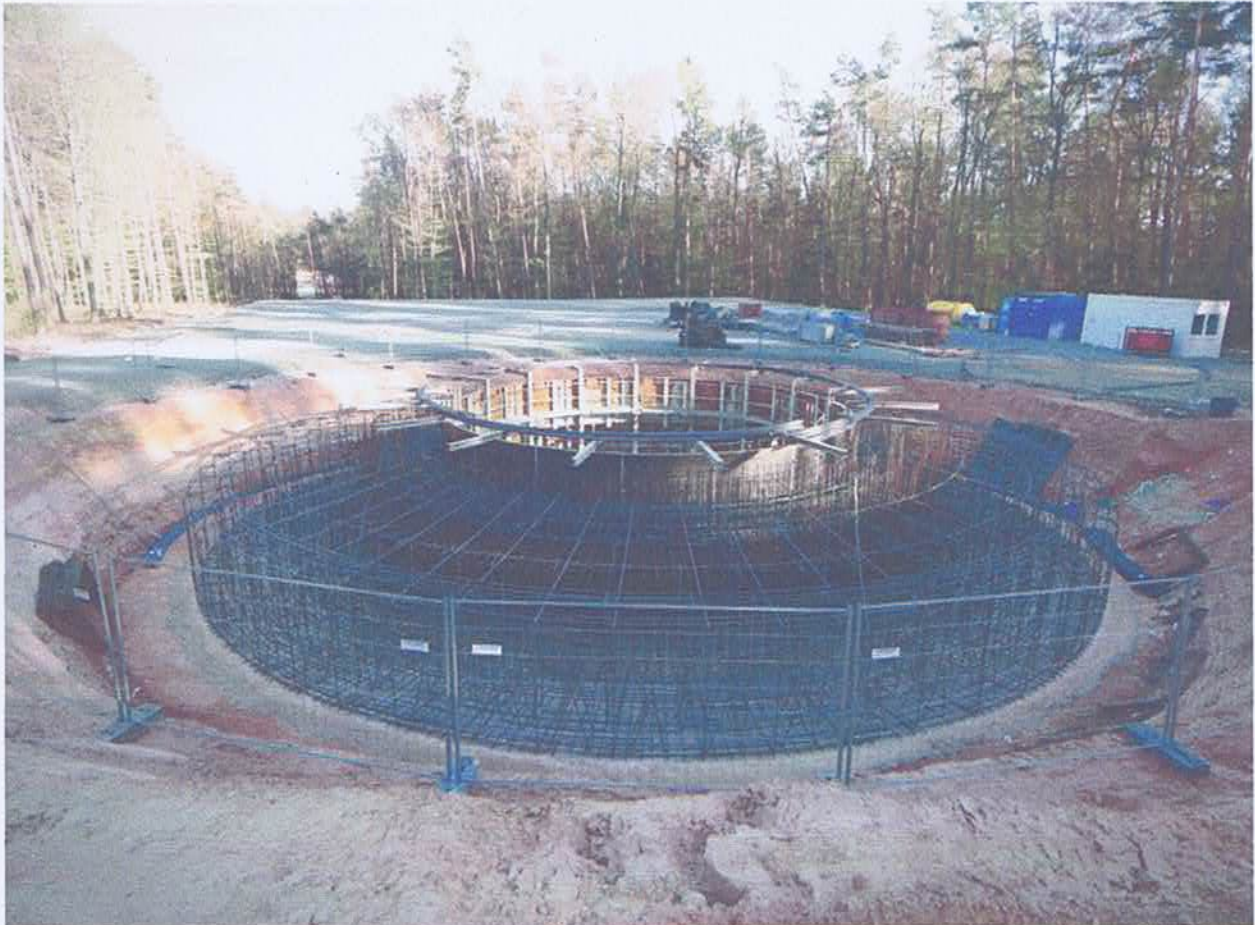
Abb. 5: Eine von unzähligen Windkraftbaustellen im Wald (Hattendorf, Hessen, April 2016).
