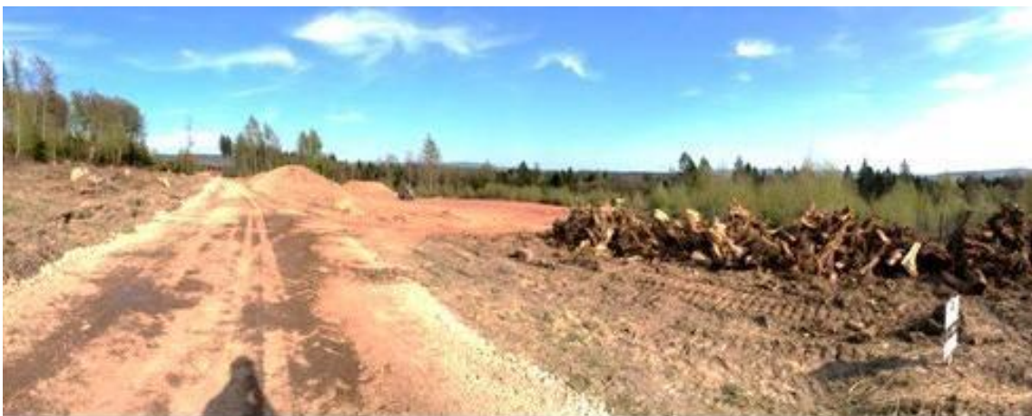
Rys. 24: Plac budowy turbiny wiatrowej w Leśnym Parku Natury Kaufunger (Hesja, 2016 r.)
