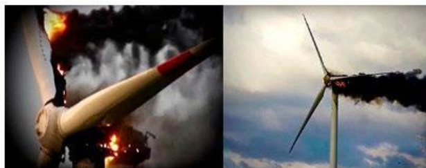
Rys. 38: Płonące elektrownie wiatrowe
