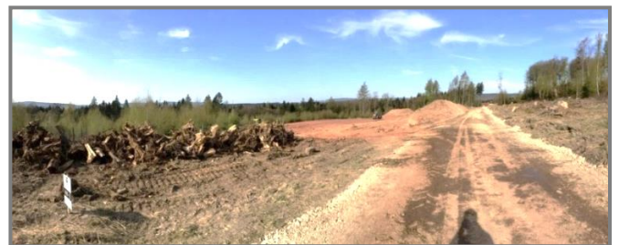
Abb. 20: Windkraft-Baustelle im Naturpark Kaufunger Wald
